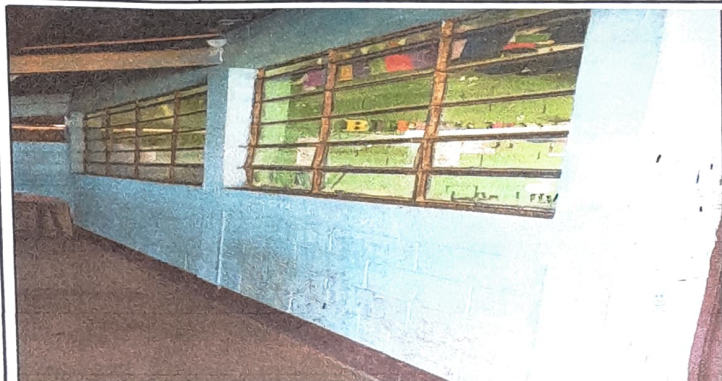
Foto1: pintura de pared y columnas interiores de todas las aulas
