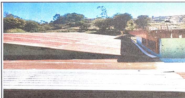
Foto 3: Techo exterior de todas la aulas
