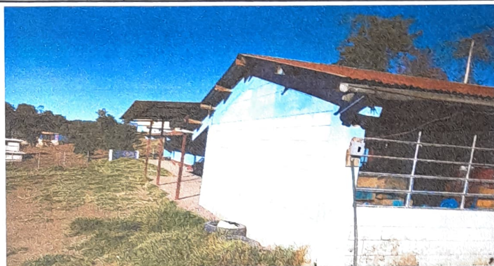
Foto 2: pintura paredes externas de aulas
