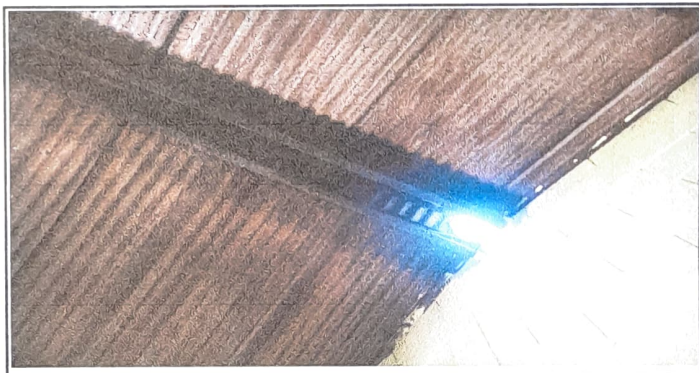
Foto 4: Techo interior aulas
